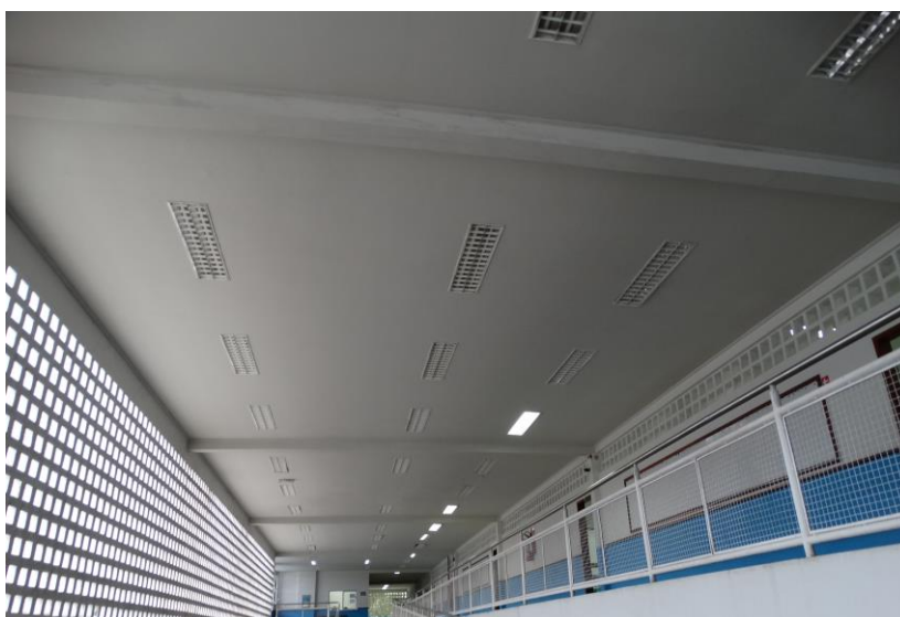
Figura 16 – Vigas que sustentam a caixa d'água na unidade
