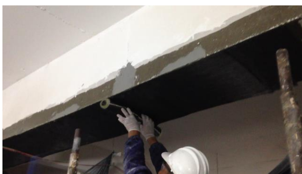
Figura 14 – Reforço estrutural com fibra de carbono em indústria
