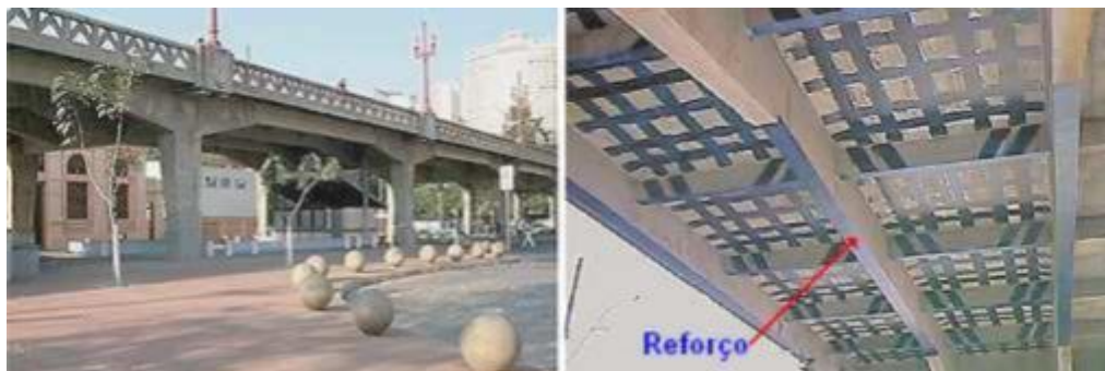
Figura 08 – Reforço com fibras de carbono no viaduto Santa Tereza
