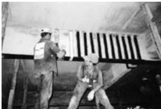
Figura 07 – Reforço de viga de concreto à flexão e ao corte
