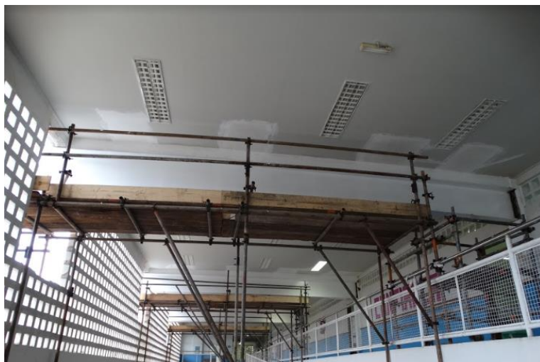
Figura 19 – V224, V225 e V226 reforçadas com perfis metálicos
